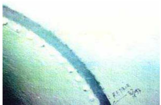
直径約1.5m, 長さ約900mの水車への導水用パイプの内・外面コーティングです。ダメージは砂混じりの水による浸食と摩滅によって引き起こされていました。セラミウム(ペースタイプ)と硬化剤CEでコーティングしました。
