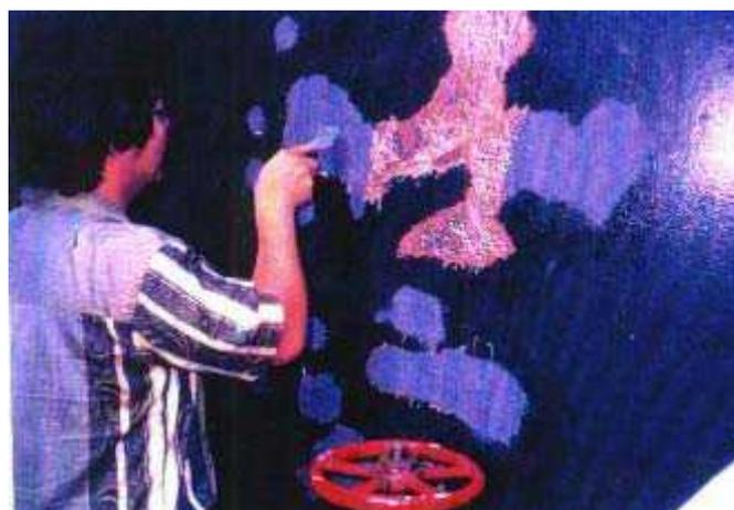
燃料貯蔵タンクの整備中に複数のオイル漏れが見つかりました。サンドブラストの後MM-メタル oL-スチールセラミックと硬化剤(赤)で直接シールしました。さらに腐食の影響を受けた部分はMM-メタル SS-スチールでコーティングしました。硬化時間を含めてポリマーメタルによる修復の所要時間は24時間、一般的な補修の方法をとっていたら、タンクを空にする作業とスチール壁の清掃を含めて溶接に6日は要したでしょう。
