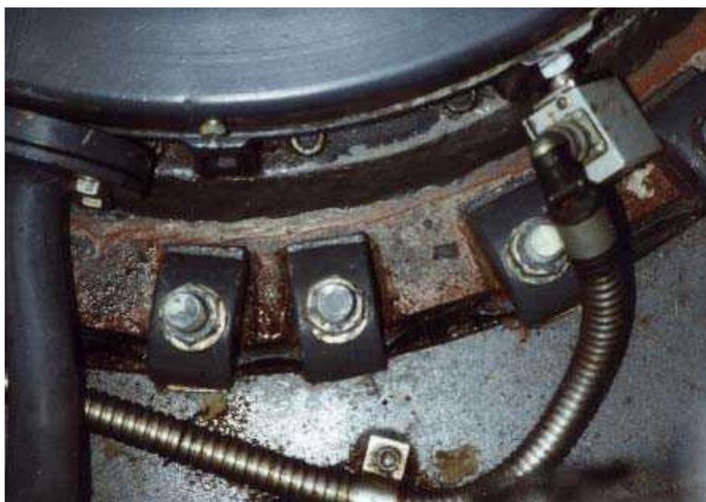
大型変圧器の負荷時タップチェンジャー装置内でタップチェンジャーのトップと切り替え装置の間の亀裂からオイルが漏れています。この補修にも「ダイレクトMM接着法」が利用されました。MM-メタルoL-スチールセラミックと硬化剤(赤)とその後硬化剤(黄)で層を増しました。
